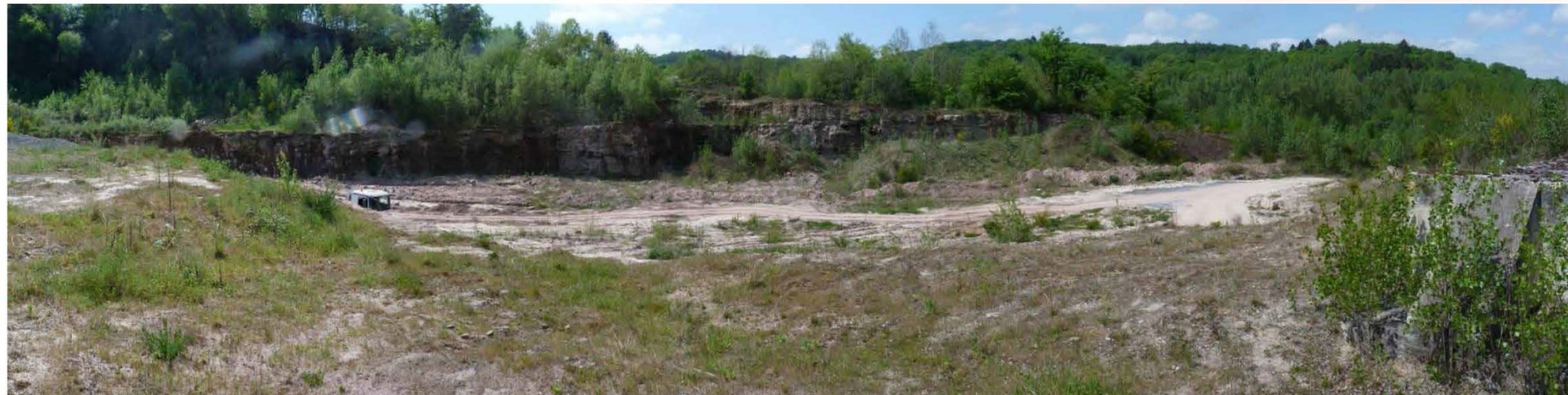
3 - Vue sur la partie Ouest de la carrière - piste d'accès à la zone d'exploitation en cours
