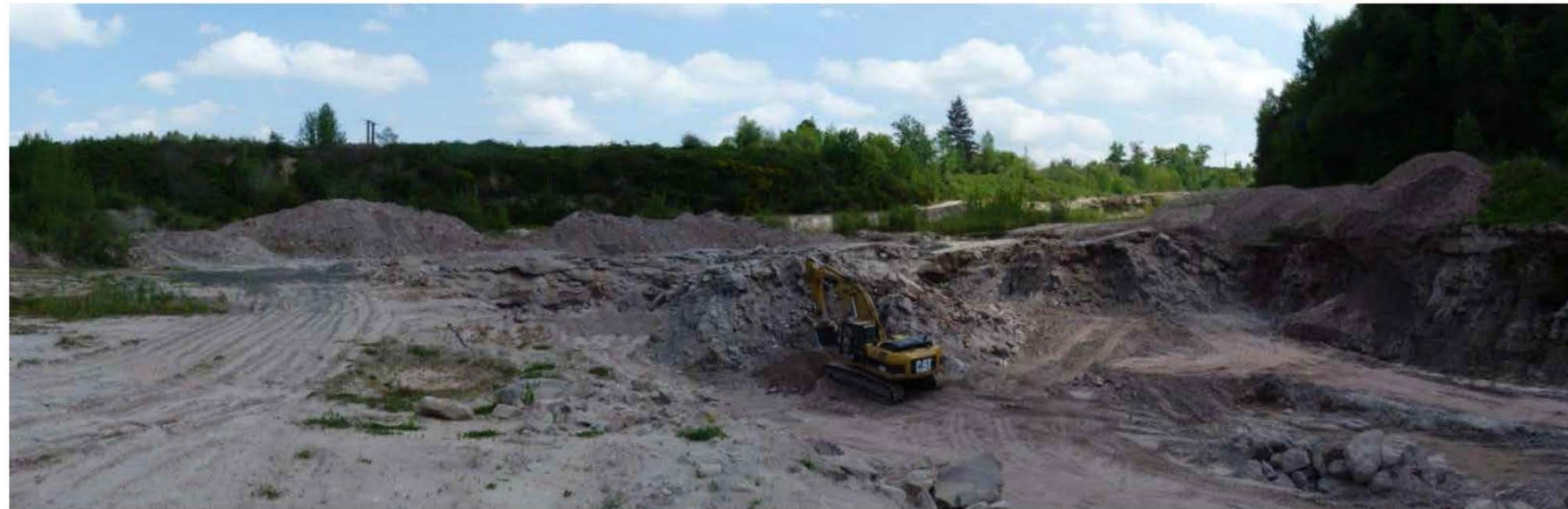
3 - Zone en cours d'exploitation
